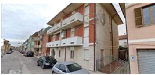
Vista fabbricato su Via Palermo
